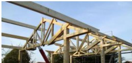
Die landwirtschaftliche Halle wurde in vier Feldern, davon eins in Massivbau die anderen mit Holzbindern mit auskragenden Vordach, erstellt. Das Bild zeigt die Tragkonstruktion des Holzbinders.
